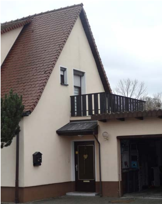
Dachterrasse als Freifläche für das Obergeschoss
