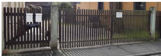
Hölzernes Hoftor aus einzelnen Latten, Pfosten aus Stein
