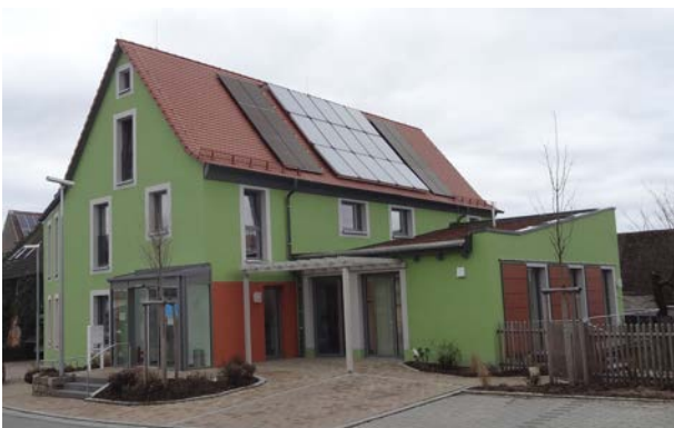
Photovoltaik- und Photothermie-Module. Die Dachränder sollten auf mind. 0,60 m frei bleiben, damit das Dach als Bauteil noch erkannt wird.
