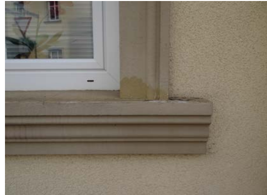
Angeklebte Show, keine Patina, nicht kompatibel mit historischen Anstrichen. Die Imitation wird bald sichtbar!
