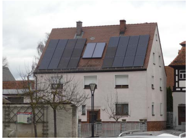
Photovoltaik und Photothermie- / Solarthermiezellen zur Warmwasseraufbereitung
