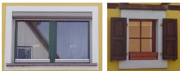
Holzfenster mit Mittelkämpfer links, modernes Sprossenfenster aus Holz rechts.
