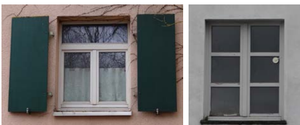
Zweiflügeliges Holzfenster mit stehendem Oberlicht links, historisches zweiflügeliges Sprossenfenster rechts.
