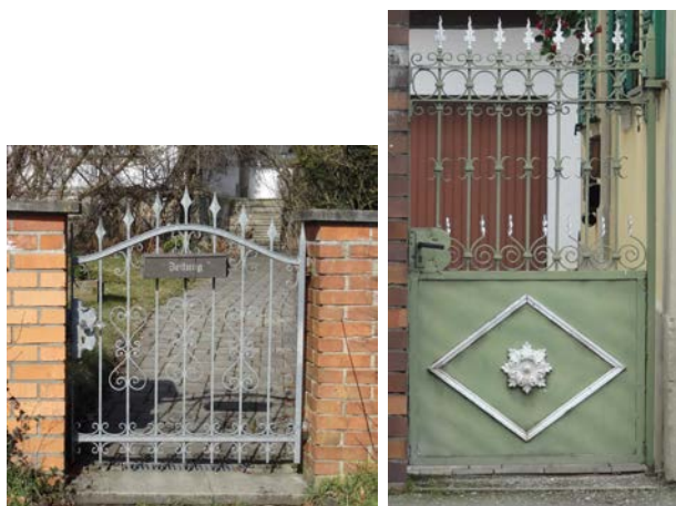
Neue niedrige Pforte links und historische mannshohe Metallpforte rechts
