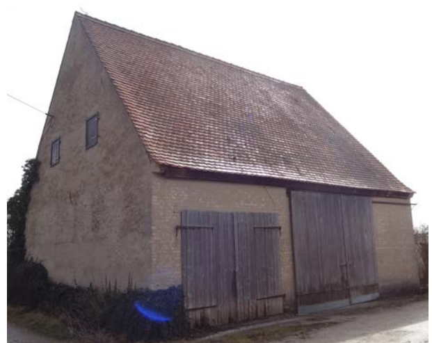
Scheune mit Belichtungsmöglichkeit im Giebel und zwei verschiedenen Toröffnungen
