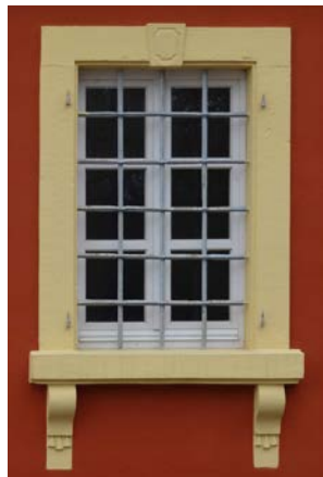
Zweiflügeliges Holzfenster mit stehendem Oberlicht links, historisches zweiflügeliges Sprossenfenster rechts.
